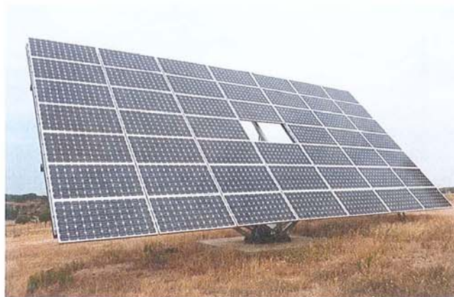
Painel da Central Fotovoltaica de Albuquerque (Badajoz)
